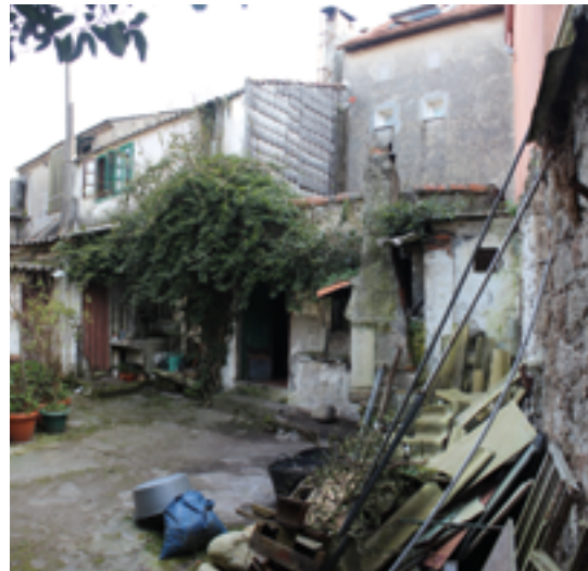
Casa unifamiliar no barrio de Elviña antes da rehabilitación. Fachada posterior.
