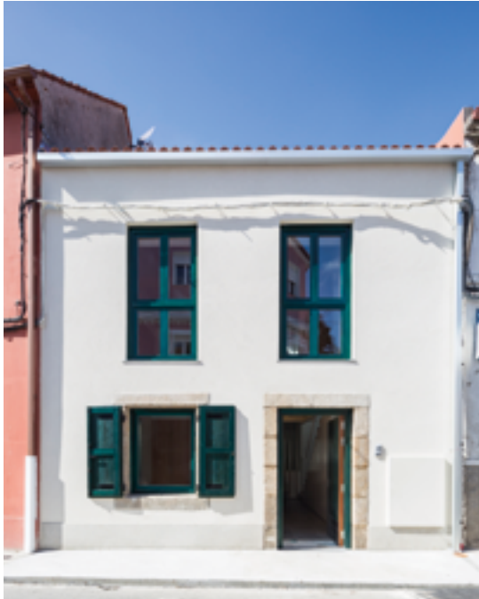
Casa unifamiliar no barrio de Elviña rehabilitada. Fachada principal.
