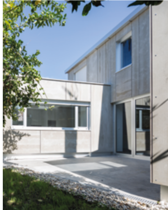
Casa unifamiliar no barrio de Elviña rehabilitada. Fachada posterior.
