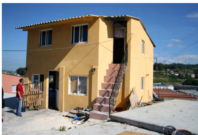
Proxecto de rehabilitación do asentamento. Dúas das vivendas nas que se interveu no cerramento exterior. Na foto de abaixo apreciase a soleira á dereita, á espera da chegada dunha vivenda prefabricada Imaxes: ASF Galicia
