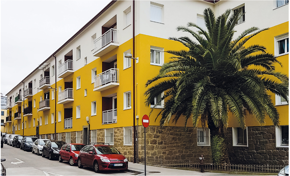
Barrio de Mariñeiros rehabilitado.
