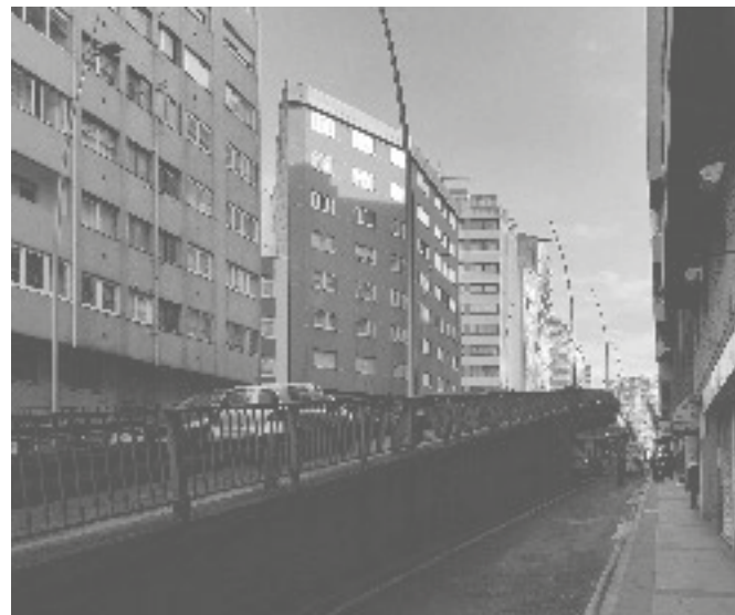
Viaduto Rolda de Nelle - Estado actual
