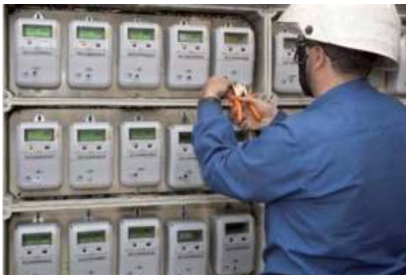
Figura 5.8: Instalación de contadores inteligentes. Fuente: El País.
