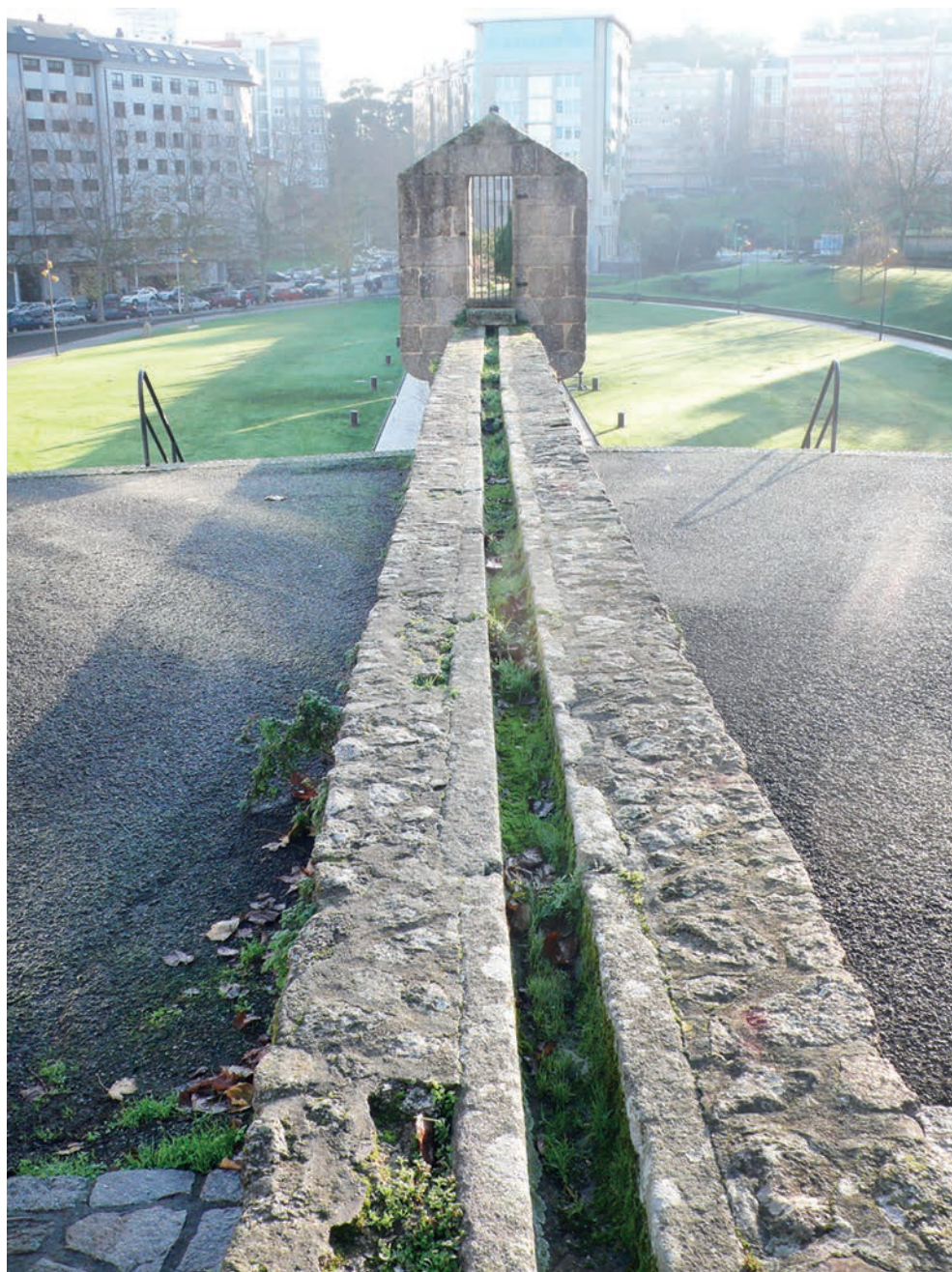
La caja del canal del acueducto. (Fotografía de C. Nárdiz).
