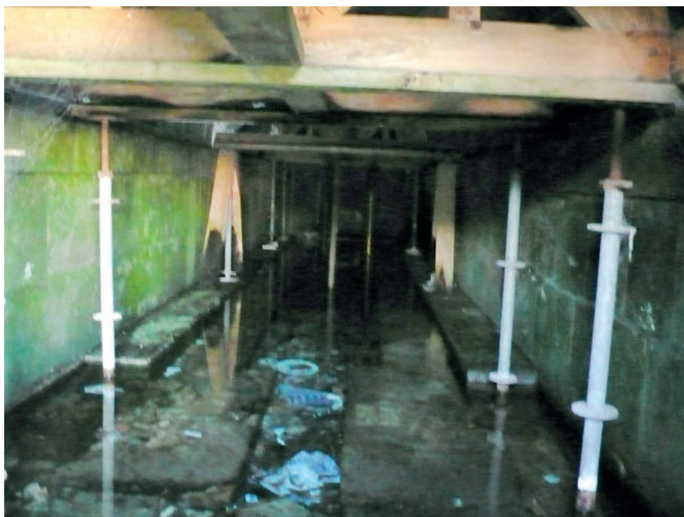
Interior de la arqueta de los Frailes. (Fotografía de C. Nárdiz).
