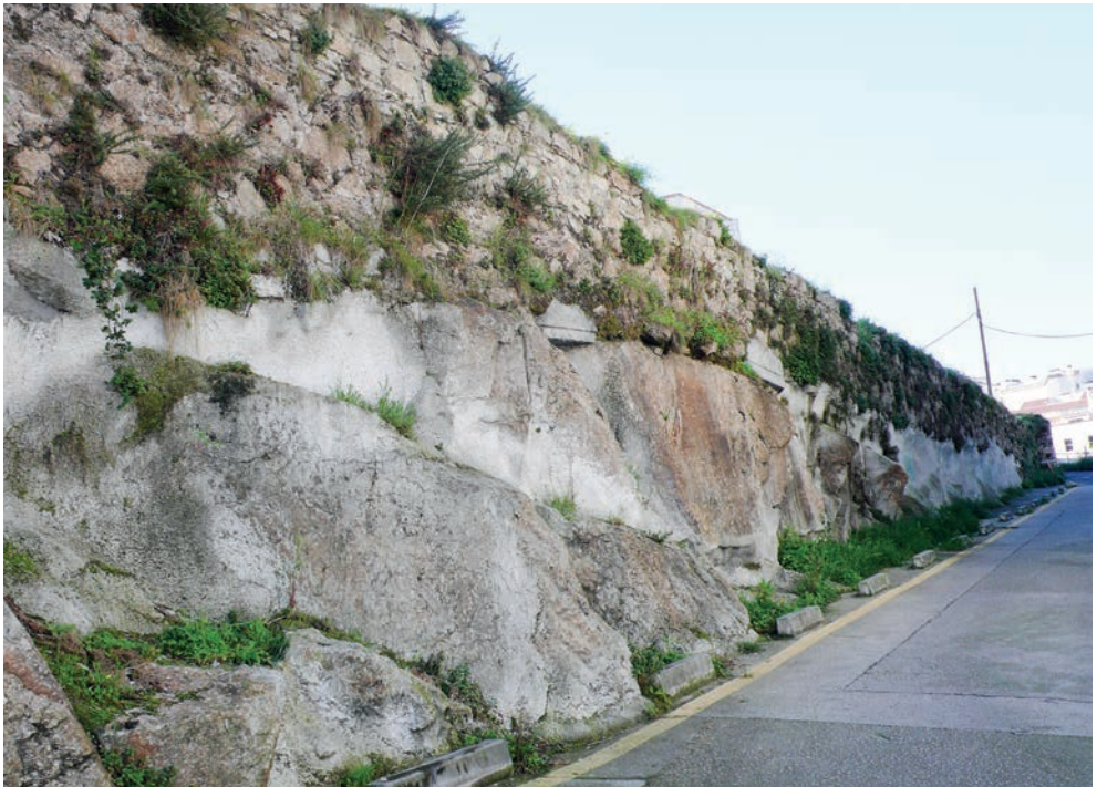
Muro de apoyo de la conducción. (Fotografía de C. Nárdiz).
