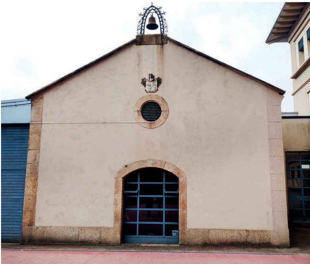
Exterior de la capilla, 2022
