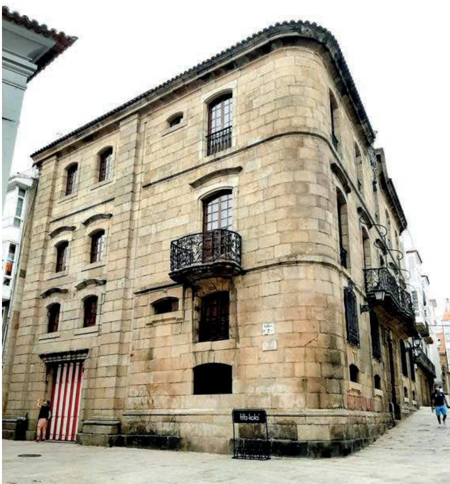
Fig. 12. Casa Cornide. Vista desde la calle Damas, con el lateral añadido a la calle Veeduría. Foto Alfredo Vigo
