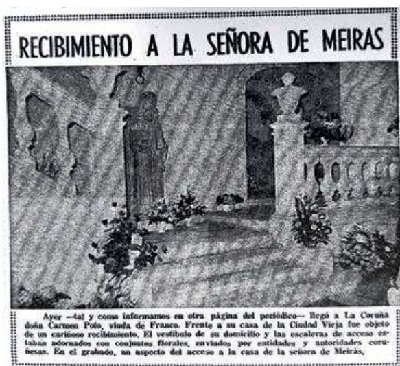
Fig. 7. Escalera principal de la Casa Cornide en 1976. Foto La Voz de Galicia
