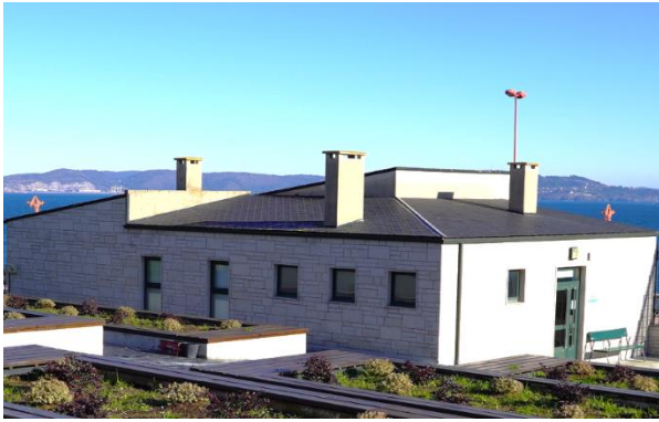
EDIFICIO DE SERVICIOS FUNERARIOS
