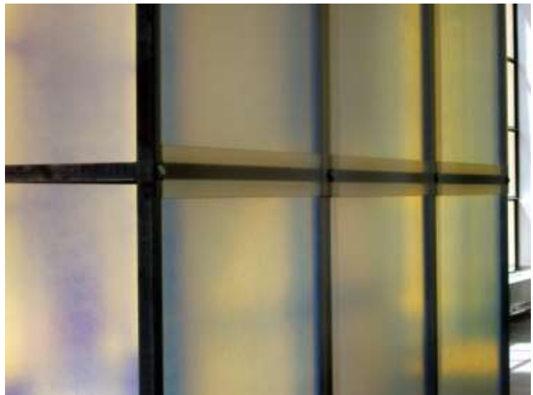
Detalle microestructura y anclaje de doble piel con fibra de vidrio lisa. Escala 1:1
