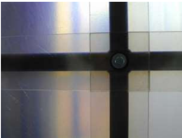
Detalle solape paneles del cerramiento externo a escala:1:1
